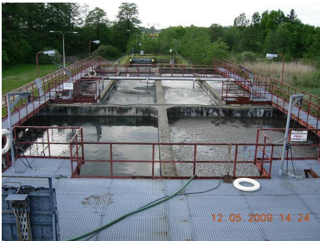
Rys.7 Komory reaktora biologicznego przed modernizacją 2009r.
