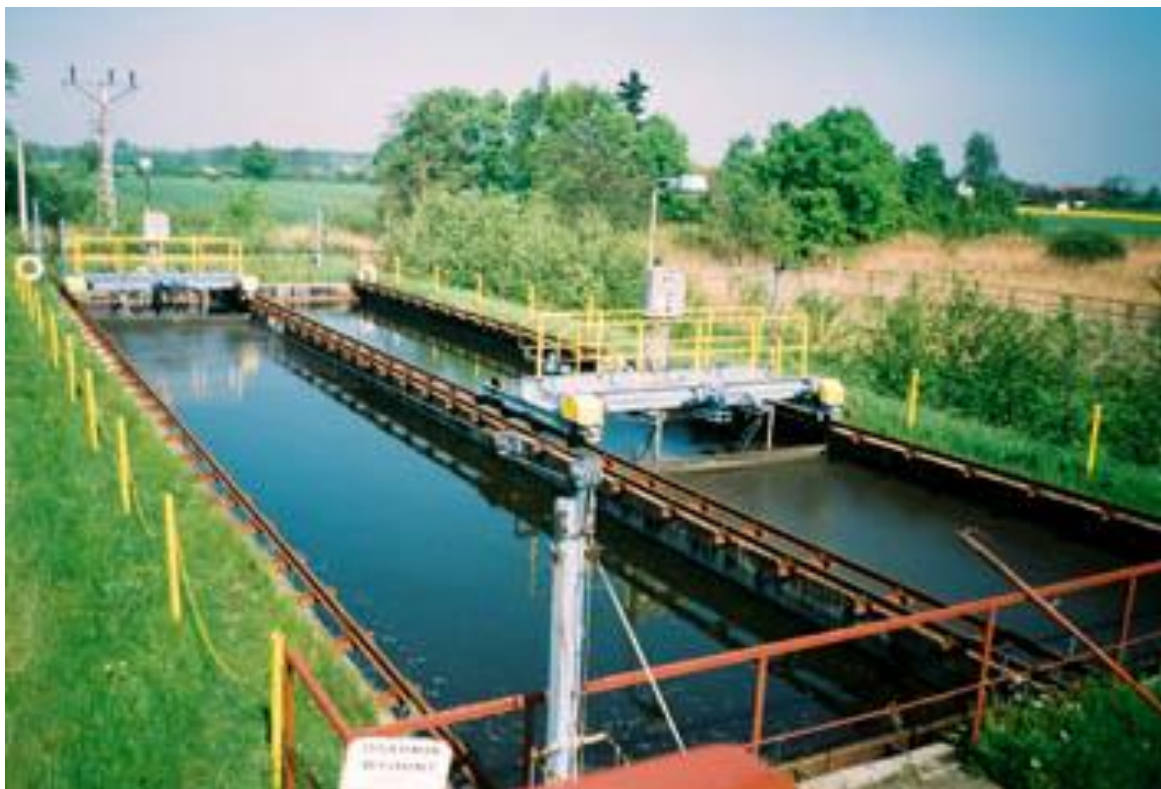
Rys.1 Osadnik wtórny przed modernizacją 2009r.
