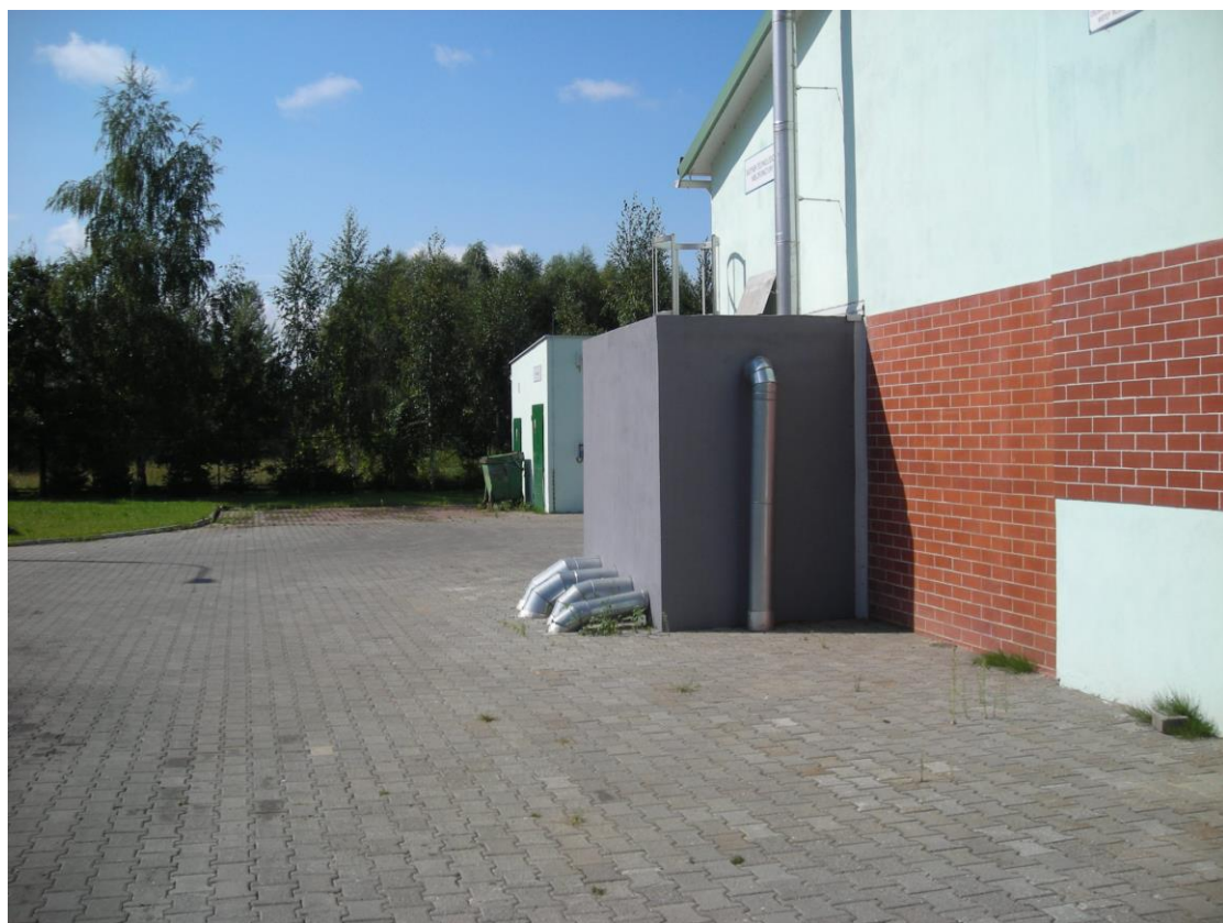
Rys.4 Komora rozprężna ścieków surowych po modernizacji 2011r.
