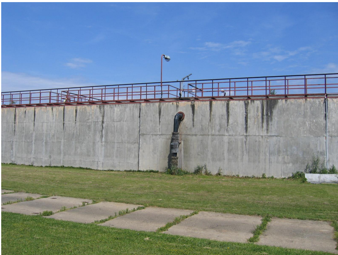
Rys.5 Reaktor biologiczny przed modernizacją 2009r.
