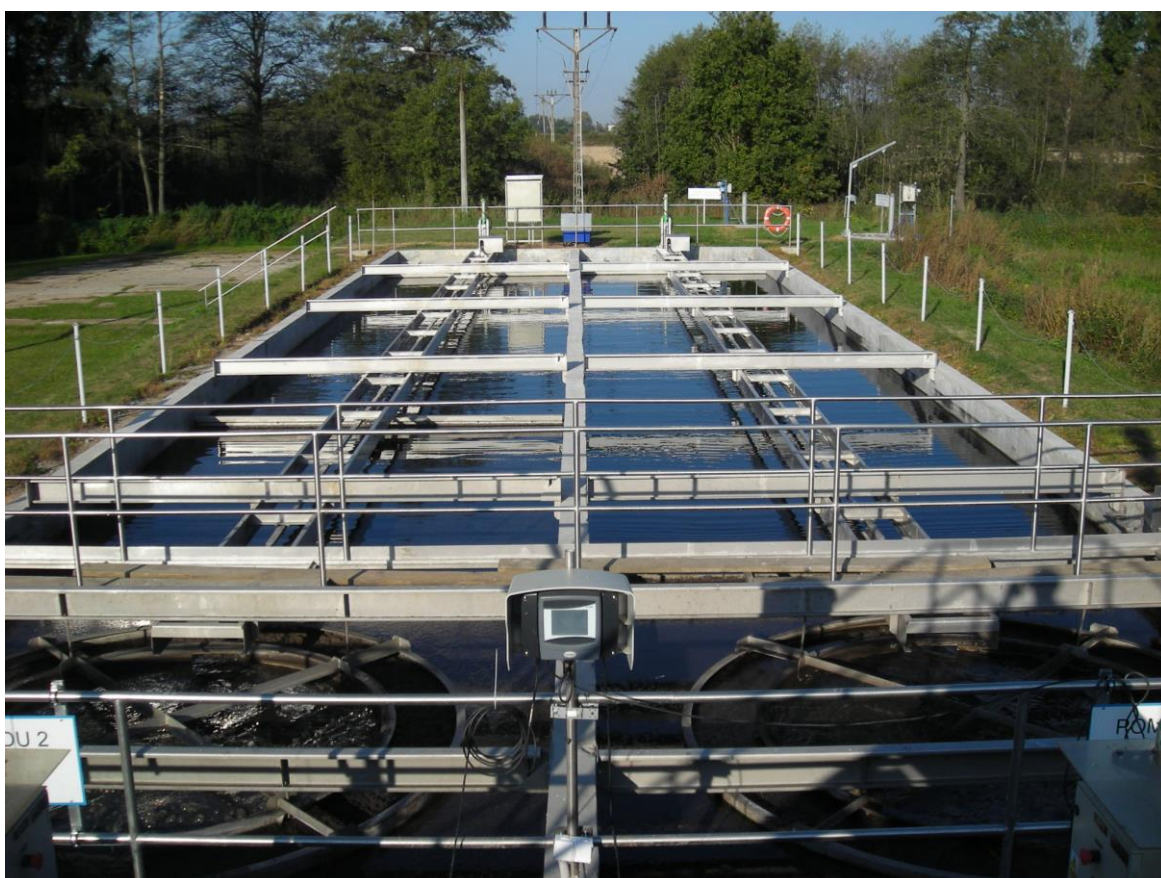
Rys.2 Osadnik wtórny po modernizacji 2011r.
