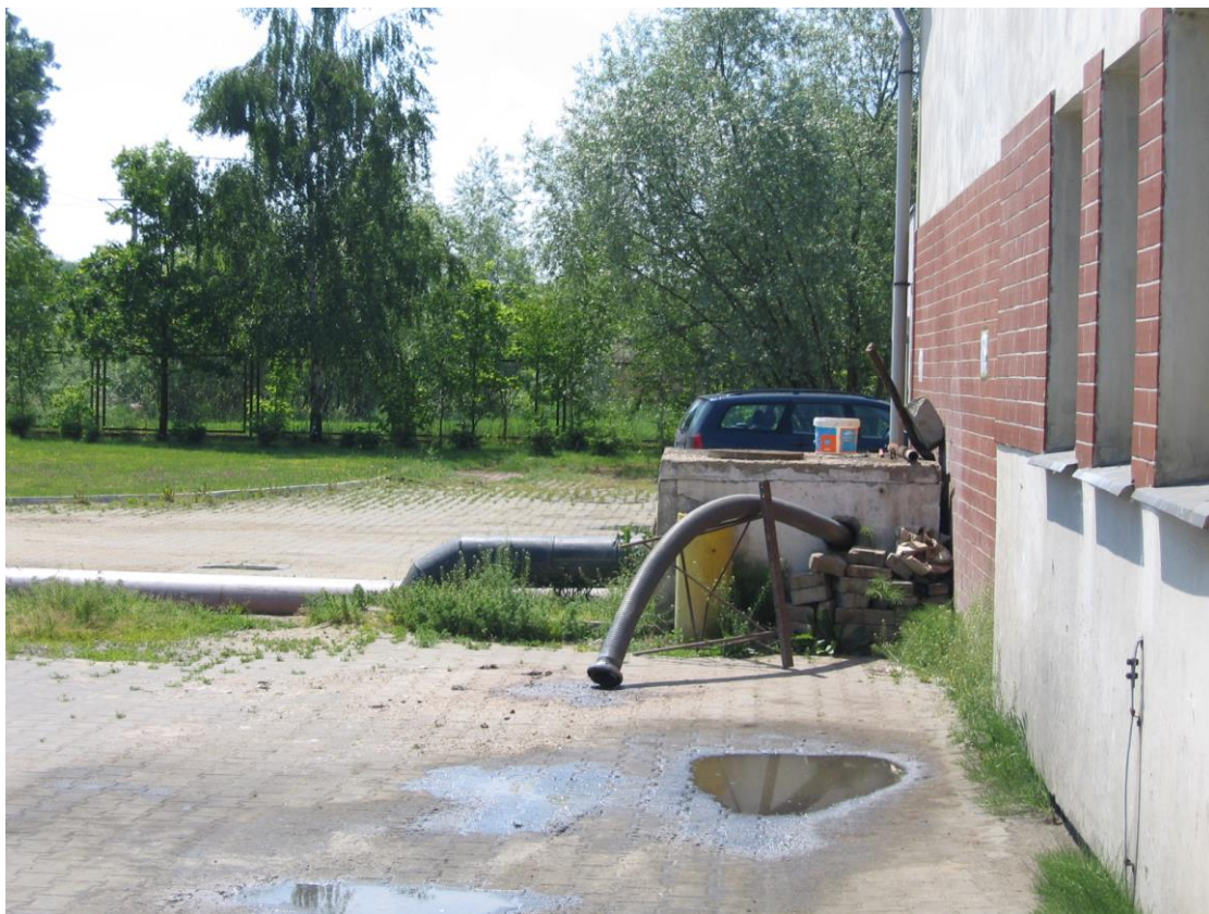
Rys.3 Komora rozprężna ścieków surowych przed modernizacją 2009r.
