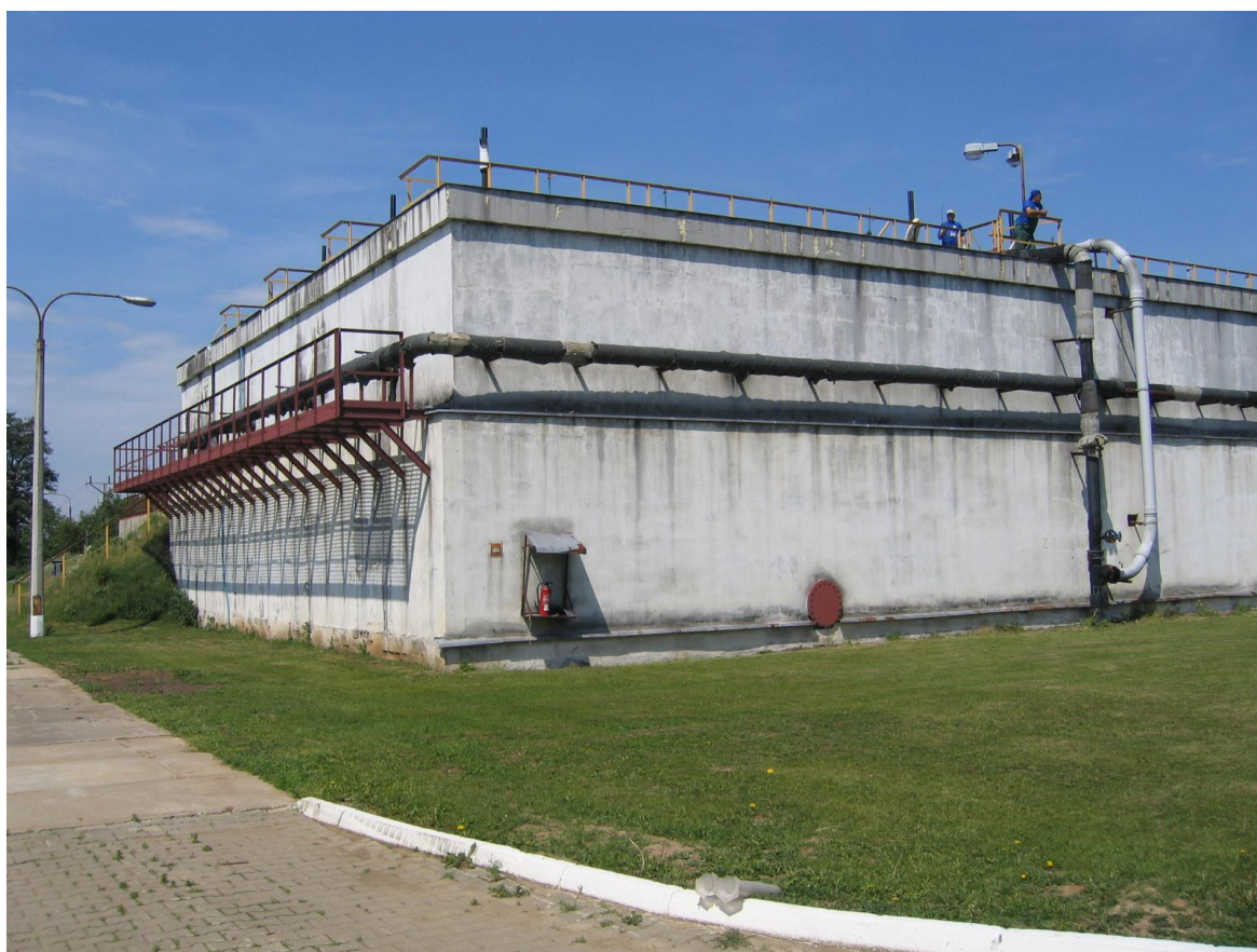
Rys.9 Zagęszczacz osadu i reaktor beztlenowy przed modernizacją 2009r.
