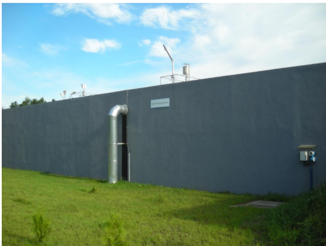
Rys.6 Reaktor biologiczny po modernizacji 2011r.
