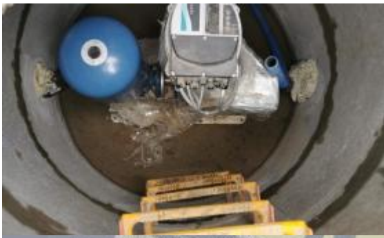
Budowa wodociągu DN 160 ok. 1300 mb Szymanów-Klanów.
